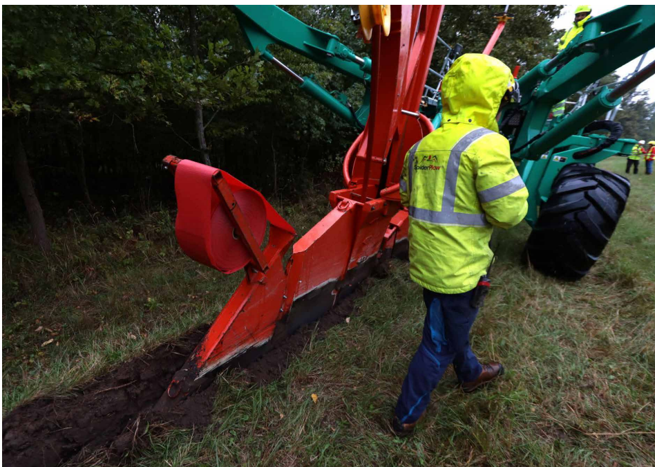
Pluhování kabelů v CHKO Soutok
