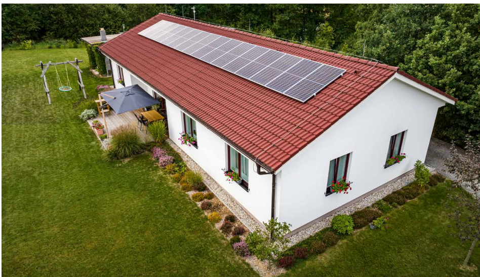
Domácí fotovoltaická instalace
